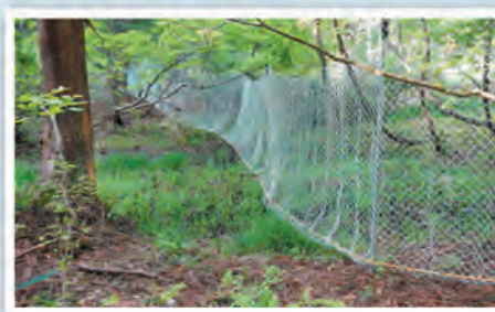
シカ柵の設置
